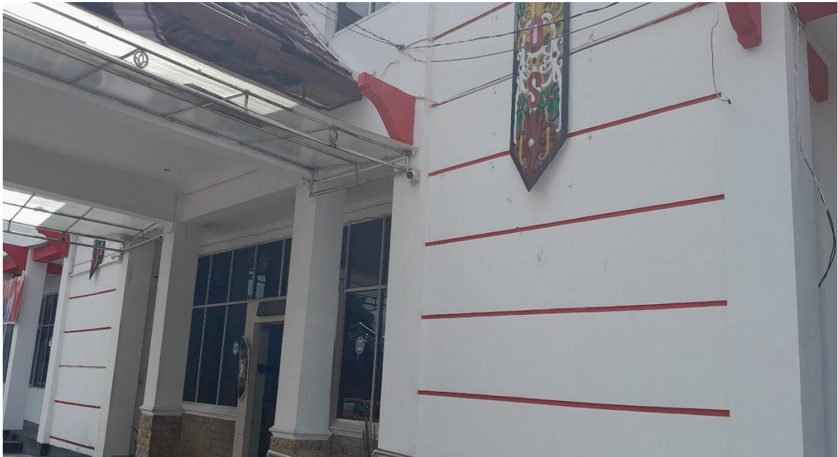
Cctv Tempat Parkir
